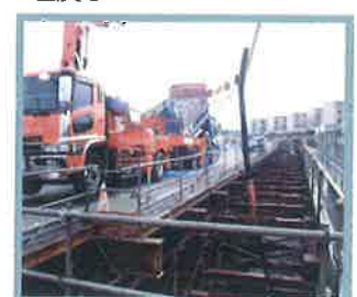
供用道路土留壁と構造物の 埋戻し
