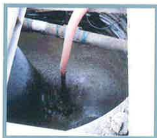
供用道路下の空洞箇所の 充填工事
