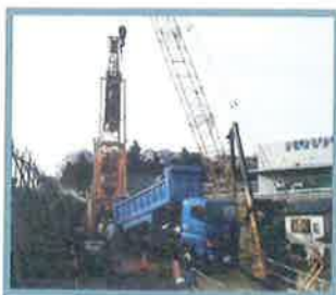
ケーシング杭の埋戻し工事
