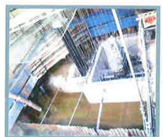
供用道路土留壁と構造物の 埋戻し
