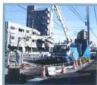
供用道路下の空洞箇所の 充填工事
